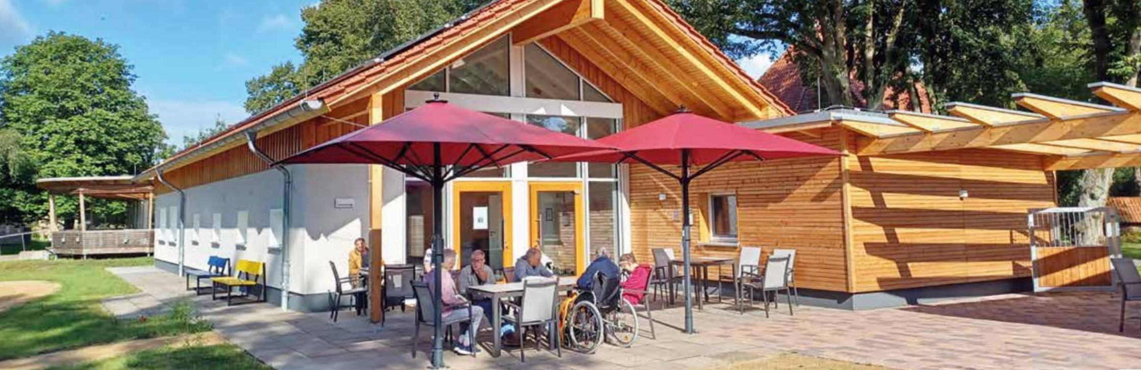
Blick auf die Terrasse am Gemeinschaftshaus Hartmannshof. Der Flachdachanbau rechts zeigt den »Würfel« vom NABU.
